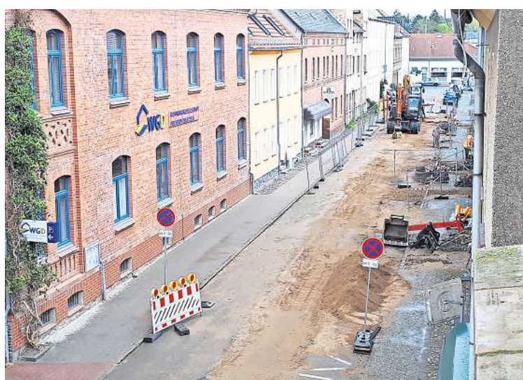
Die Bauarbeiten sind mittlerweile in die Mitte der Elisabethstraße vorge-rückt. FOTO: CHRISTINE JACOB
